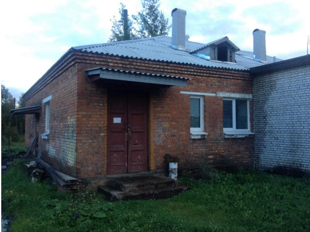
Рисунок 3. Общий вид котельной д.Сухое
